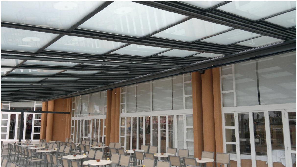
Imagen 3.- Techo Skyglass al 80% de apertura con hojas cerradas y vidrios blanco mate
